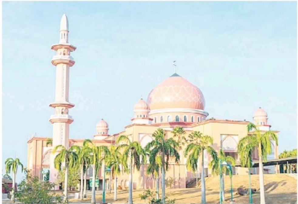
INDAH: Masjid UMS atau lebih dikenali sebagai 'Pink Mosque' dalam kalangan pelancong antara destinasi tarikan pelancong antarabangsa di kampus UMS.
