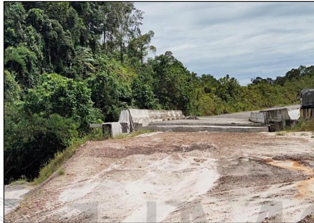
Gambar 1.3: Tanah yang terdedah untuk pembinaan Jambatan Sg. Kua.
