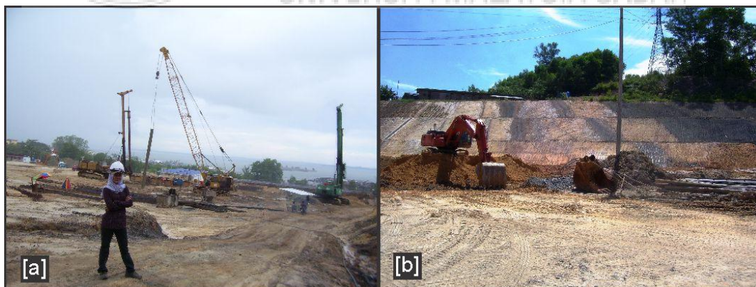
Rajah 1.2: Aktiviti pembinaan bangunan yang dilakukan di Jalan Leila, lokaliti JLE (a) dan lokaliti S2JBS (b).
